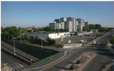
6.5 - VUE AERIENNE DEPUIS LE PONT - EXISTANT
